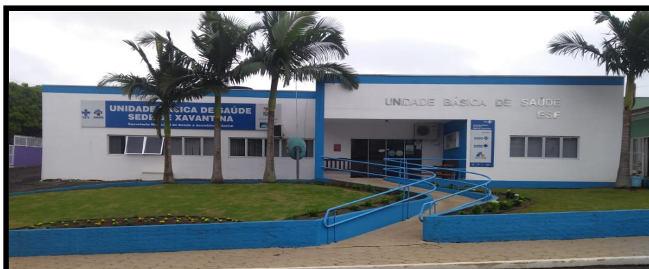
Figura 35 - Fachada Frontal da Unidade Básica de Saúde para a Rua Prefeito Octávio Urbano Simon
