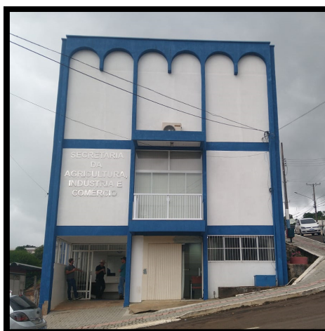
Figura 33 - Fachada Frontal da Casa da Cultura para a Rua Prefeito Octávio Urbano Simon
