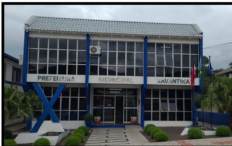
Figura 37 - Fachada Frontal do Centro Administrativo para a Rua Prefeito Octávio Urbano Simon
