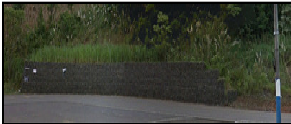
Figura 43 – Muro de Gabião objeto de instalação
