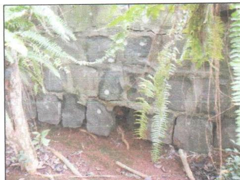
Figura 10. Muro de contenção de encosta com rachaduras devido ao sobrepeso de aterro existente..
