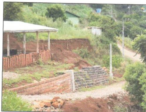
Figura 14. Foto evidenciando a contenção com pneus – ineficiente – onde já ocorreu um deslizamento.
