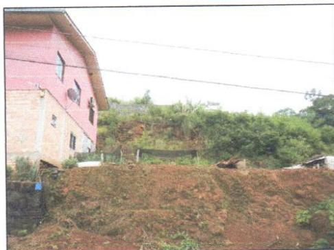
Figura 5. Talude de corte e aterro evidenciando material de baixa competência, susceptível a deslizamentos. Muro de contenção ao fundo.
