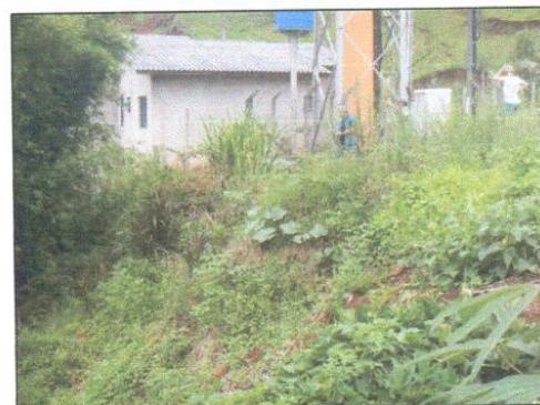
Figura 8. Solo de baixa competência onde já ocorreu pequeno deslizamento.
