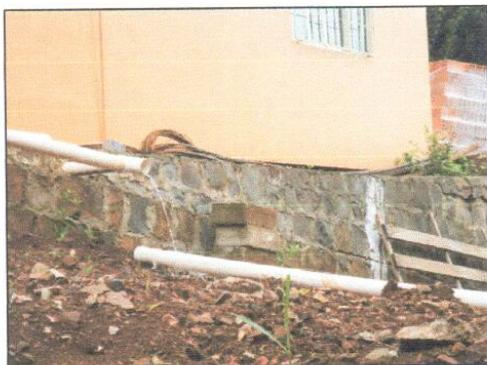
Figura 9. Lançamento de água servida em aterro.
