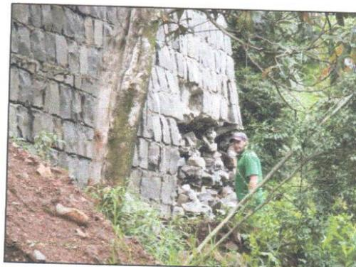
Figura 20. Detalhe do muro de contenção que não suportou a sobrecarga vindo a desmoronar.
