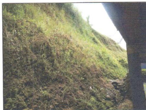
Figura 12 Nesta foto observa-se o material, de baixa coesão e poroso – frágil.
