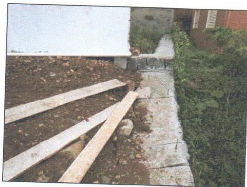
Figura 19. Rachaduras visíveis no muro de contenção.
