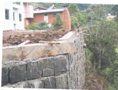
Figura 18. Muro de contenção construído sem nenhum critério técnico.
