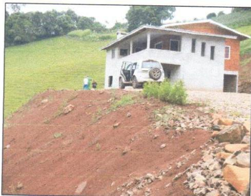
Figura 13. Talude de corte evidenciando material de baixa competência, susceptível a deslizamentos.
