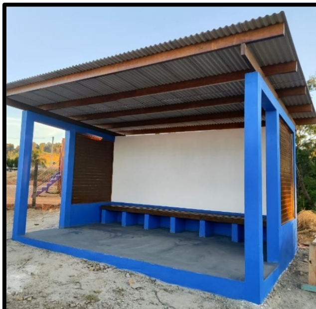
Figura 48 – Imagem da Fachada Frontal da Parada de Ônibus
