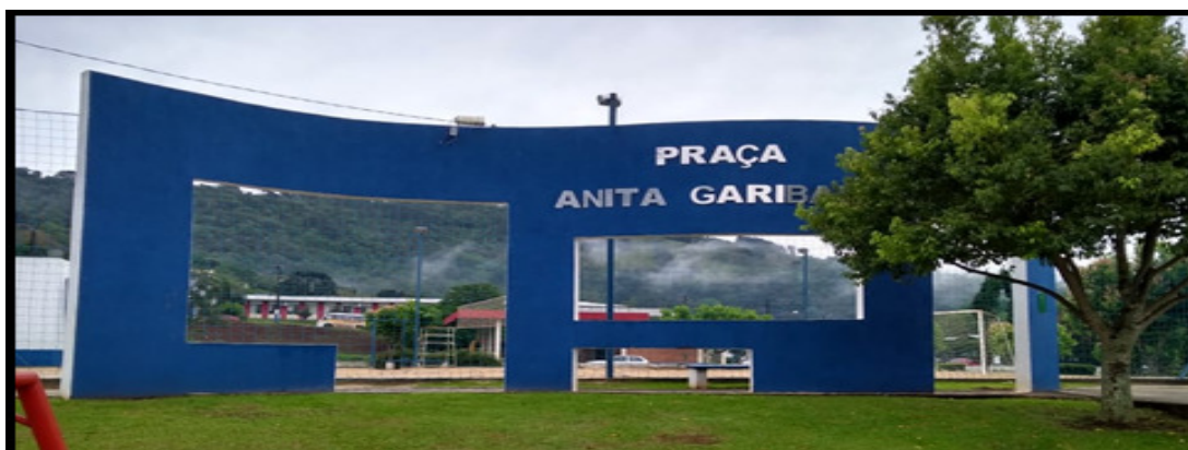
Figura 29 – Imagem da fachada do Pórtico, voltada para a Rua Irineu Bornhausen
