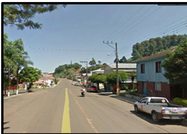
Figura 52 - Imagem da locação dos Postes localizados no longo da Rua Principal (Rodovia SC - 155) e objeto de instalação das Figuras Natalinas
