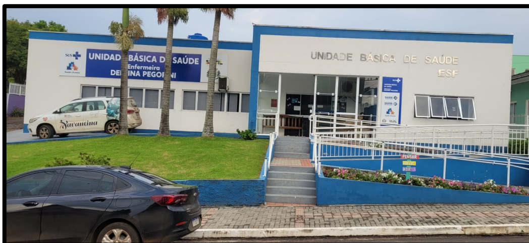
Figura 41 - Fachada Frontal da Unidade Básica de Saúde, para a Rua Prefeito Octávio Urbano Simon
