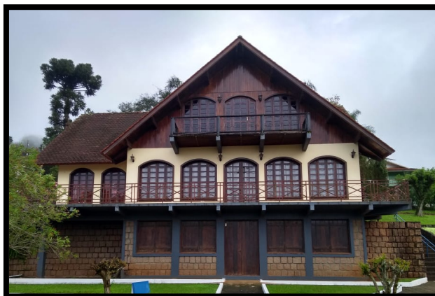
Figura 5 – Fachada da Casa do Idoso, voltada para a Praça Rio Branco
