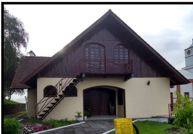
Figura 4 - Fachada da Casa do Idoso, voltada para a Rua Praça Rio Branco
